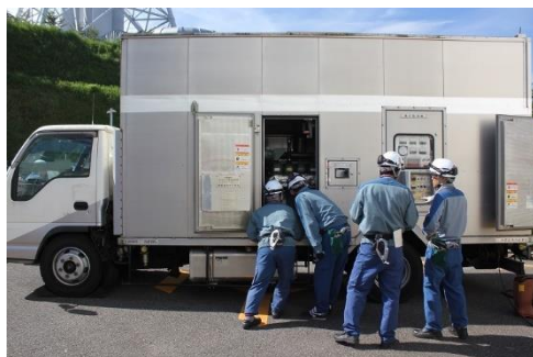
電源車の使用前点検
