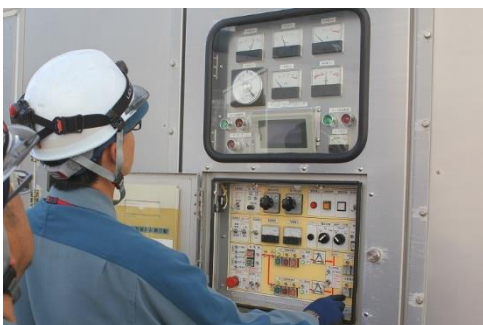
電源車起動後の電圧・周波数の調整
