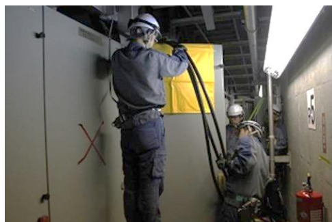
ケーブル接続（電源盤側）
