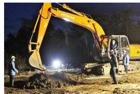
陥没箇所の埋め戻し
