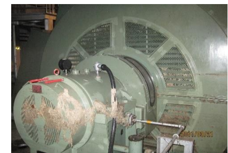
津波により被害を受けた発電機 （平成23年3月21日撮影）
