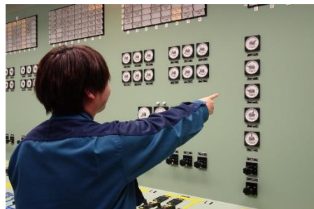
所内電源の受電状況を確認
