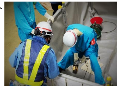
火気作業場における危険箇所の確認
