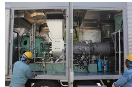
運転後のガスタービンの確認
