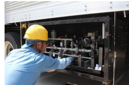
燃料配管の点検
