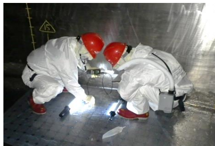
タンク底板の肉厚測定
