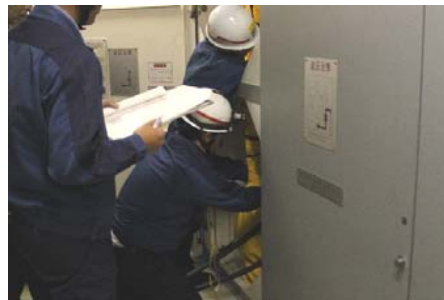
電源盤へのケーブル接続
