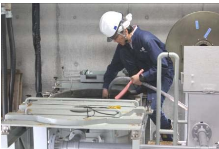
検出槽の清掃
