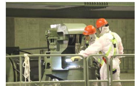
燃料交換機の点検（拡大）
