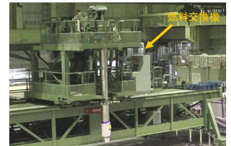
燃料交換機の点検
