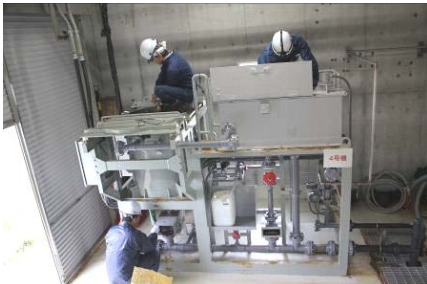
放水口モニタの設備内に堆積した砂の除去
