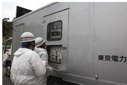
起動後のデータ確認
