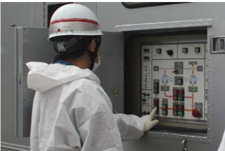
電源車の起動
