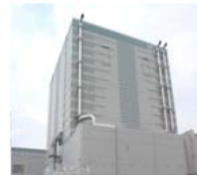
3号機原子炉建屋全景
