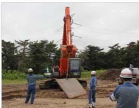
埋め戻した箇所への鉄板設置
