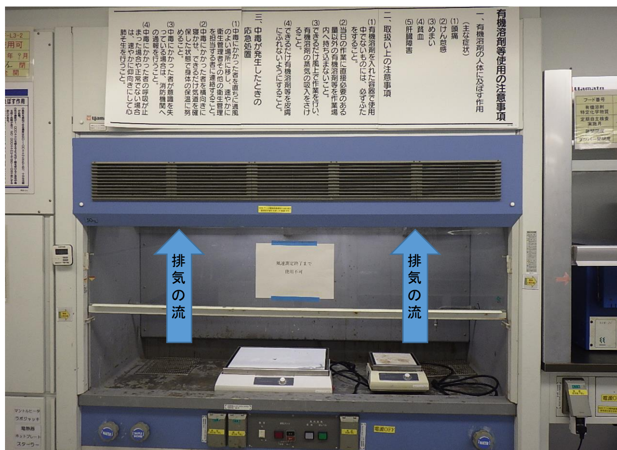
定期自主検査を実施せずに有機溶剤を使用した当該装置
