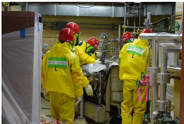
<1号炉除染作業>
