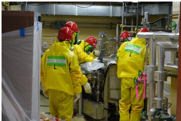
<1号炉除染作業>
