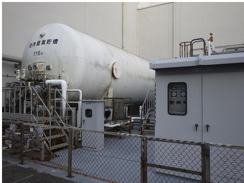
＜格納容器内ガス濃度制御系＞
