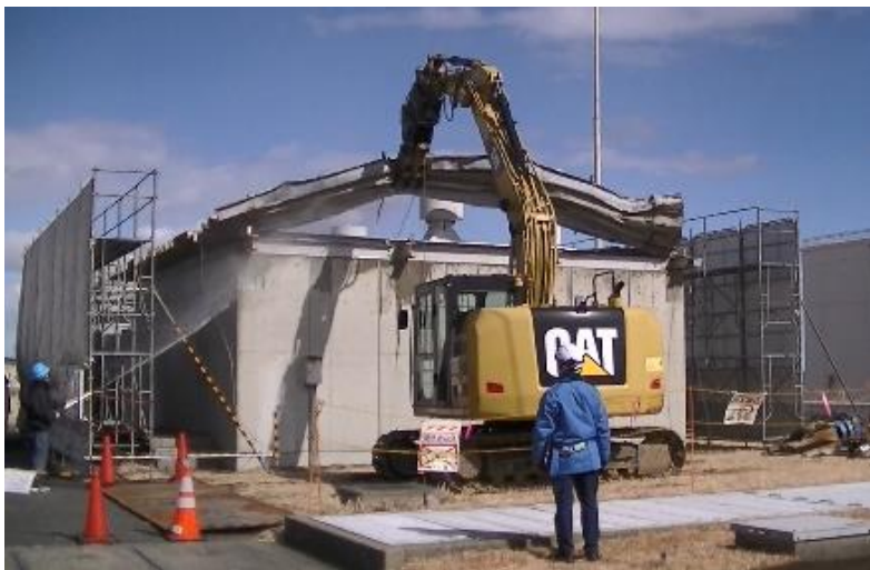
< 3 / 4号炉予備ポンベ建屋解体作業 >
