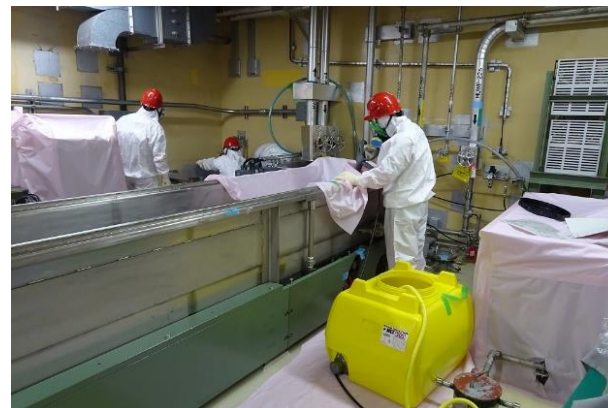
<3号炉除染作業>
