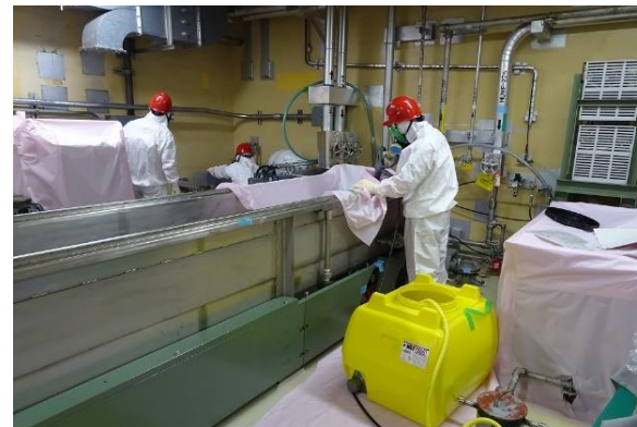
<3号炉除染作業>
